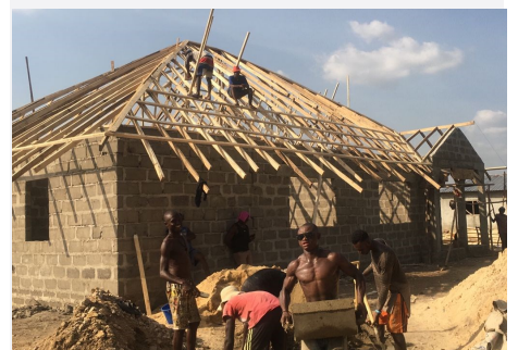
Het opvanghuis in aanbouw
